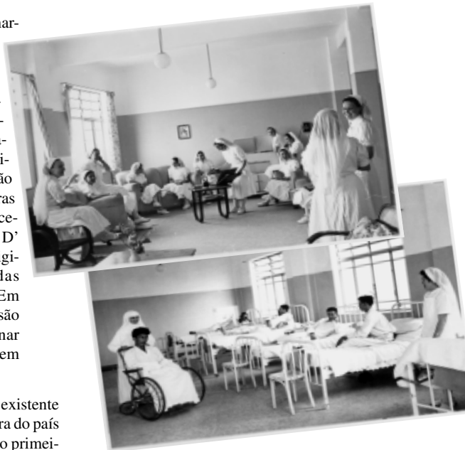
Franciscanas Missionárias de Maria - residência da Escola de Enfermeiras da EPM (foto acima) e enfermaria do Hospital São Paulo (abaixo)
